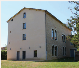
Elévation nord. Les baies géminées qui se distinguent par leur forme et leur taille rendent compte de la fonction première de l'édifice : une école d'art.
