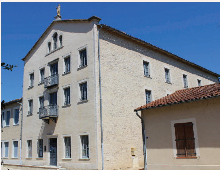
Centre socio-culturel intercommunal en 2013. Entre 2008 et 2010, les travaux de réhabilitation sont menés par le Pavillon Architectures de Toulouse.
