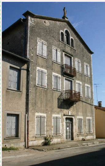
Vue de la façade (ouest) en 2006 avant les travaux de réhabilitation.
