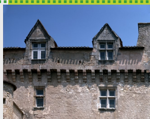
Élévation sud du château, détail des mâchicoulis et des lucarnes. Photo. Ch. Soula, 1989.
