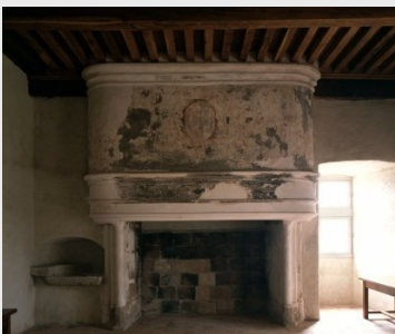
Château, cheminée du 2 e me étage. Photo. J.-F. Peiré, 1989.
