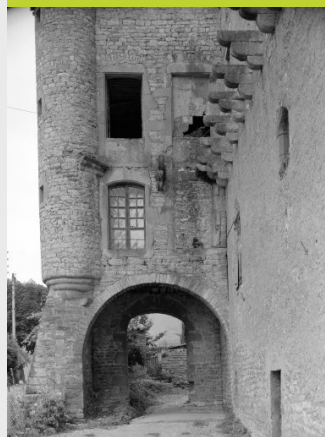
Vue du châtelet d'entrée, côté ville. Photo. Ch. Soula, 1979.
