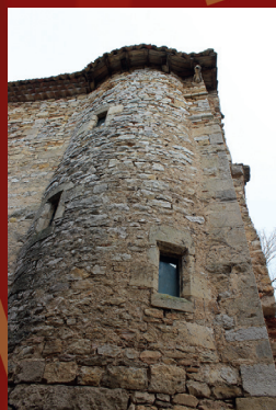
Tour d'escalier en vis.
