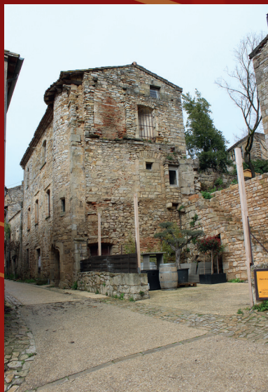
Photographie de l'emplacement de la maison en 2020 et de la tour d'escalier en vis conservée sur la maison mitoyenne.
