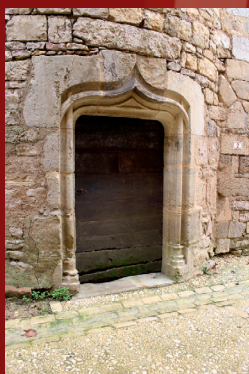
Porte d'entrée dans la tour avec un linteau en accolade.
