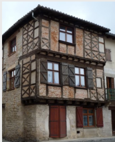
Élévation sur la place du 19, Grande-Rue.
