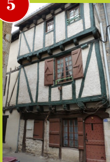
Façade du 24, rue des Templiers.
