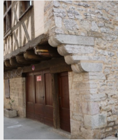
Tête de mur au 23, Grande-Rue.
