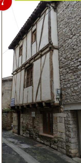
Les constructions en série des XV e et XVI e siècles au sud du faubourg.
